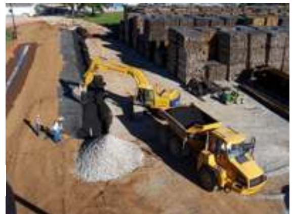
透過性浄化壁工事状況
