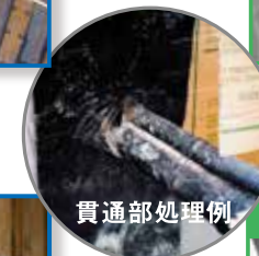
ピーコンや打継ぎ、ジャンカなどはシールで処理する。
