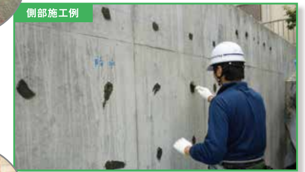
ピーコンや打継ぎ、ジャンカなどはシールで処理する。
