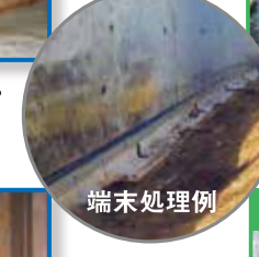
シートパイルにベニヤ板を設置して、ボルテックスを施工する。
