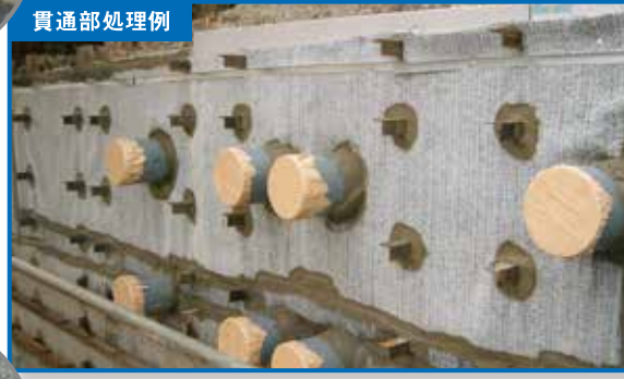
スリーブ管は予め設置しておき、貫通処理を施す。
