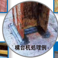
凹凸差の著しい箇所は、ベントナイトなどで不陸調整する。
