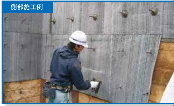
タッカーなどを使用してボルテックスを施工する。
