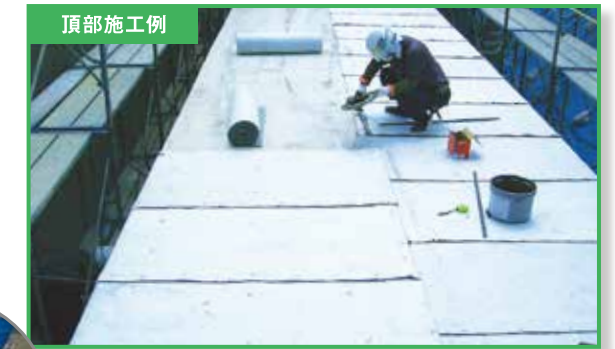
割付けに従いながら施工する。
