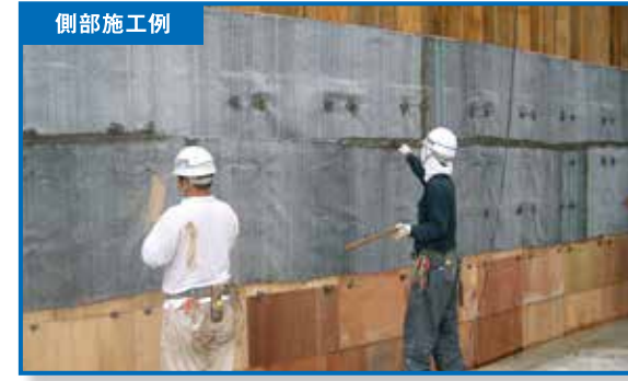
シートパイルにベニヤ板を設置して、ボルテックスを施工する。
