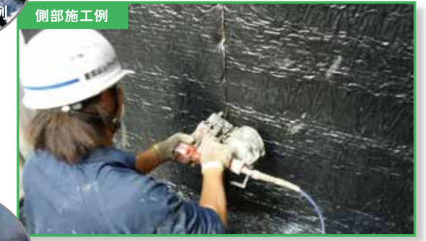
釘打ち機を使用してボルテックスを固定する。
