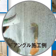
スリーブ管は予め設置しておき、貫通処理を施す。
