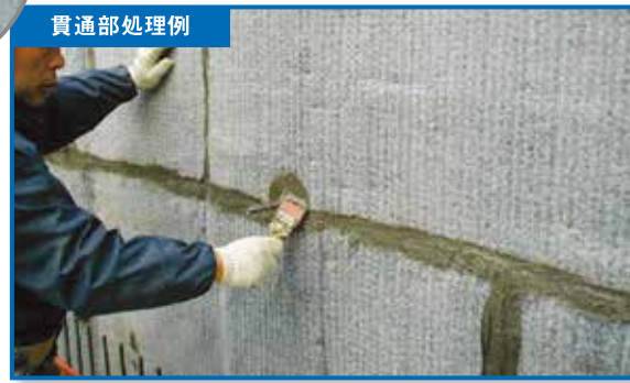
セパレーターの貫通部や重ね部には、ベントシールを盛り付ける。
