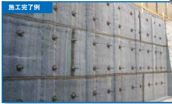
ボルテックスの端部は、GLより100mm以下に合わせる。
